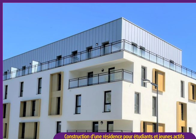
Construction d'une résidence pour étudiants et jeunes actifs Chartres - 3F Centre-Val de Loire
