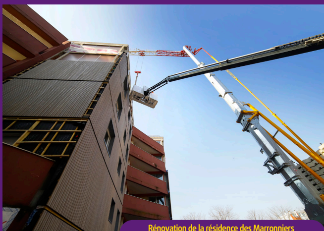
Rénovation de la résidence des Marronniers Fleury-les-Aubrais (45) - LogemLoiret
