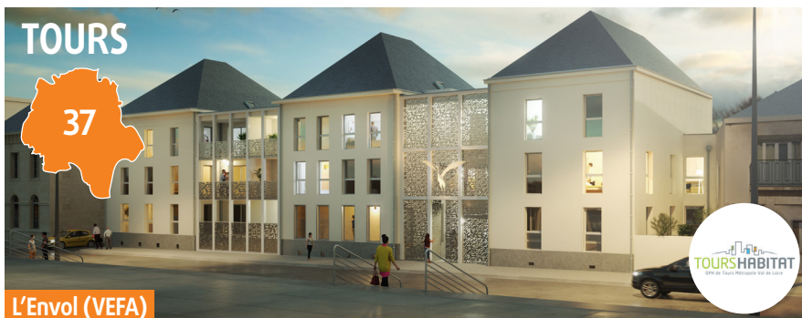
Construction de 11 logements neufs (PSLA)
