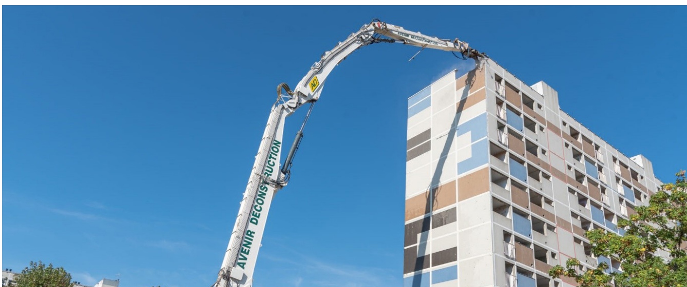
La résidence Sainte-Hélène en cours de démolition – Scalis (© Benjamin Steimes – photographe Châteauroux Métropole)
