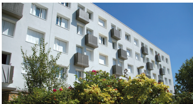
Une résidence en cours de réhabilitation aux Favignolles - Terres de Loire Habitat
