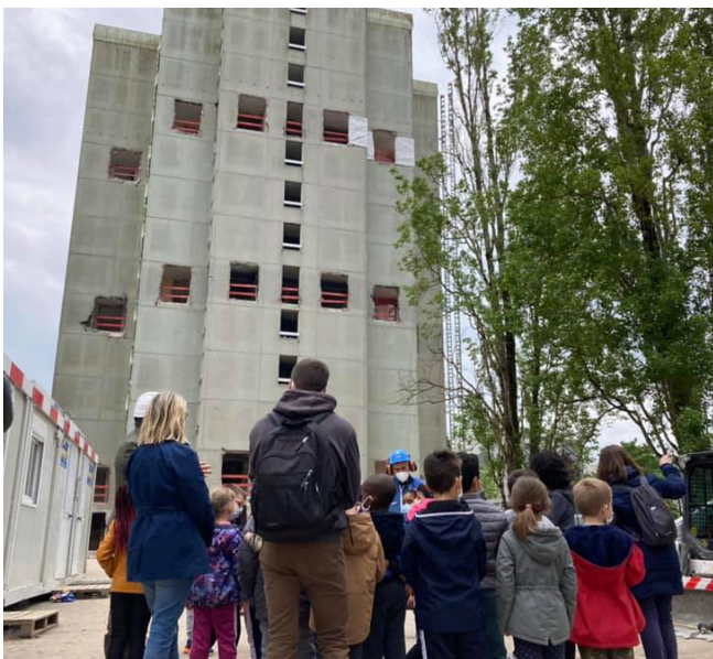
Une action de sensibilisation des habitants avant démolition - Val de Berry
