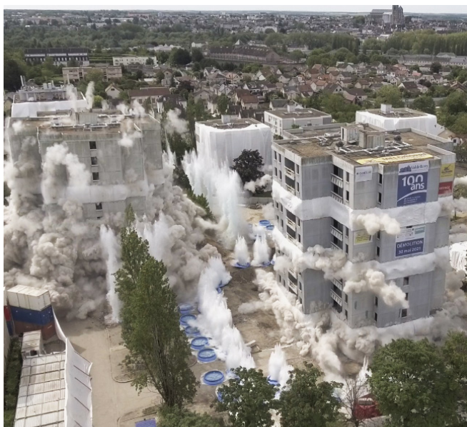
La démolition par foudroyage de la résidence du Grand Meaulnes - Val de Berry
