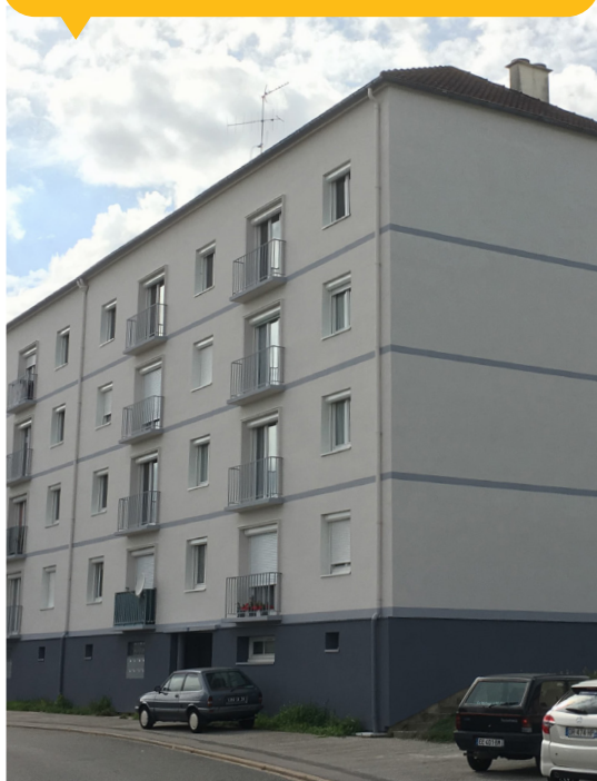
Immeuble après travaux
