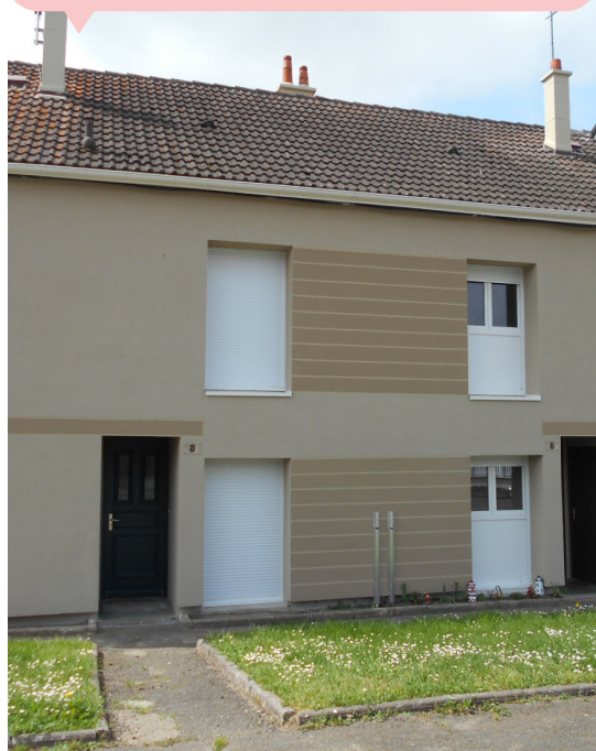
Immeuble après travaux
