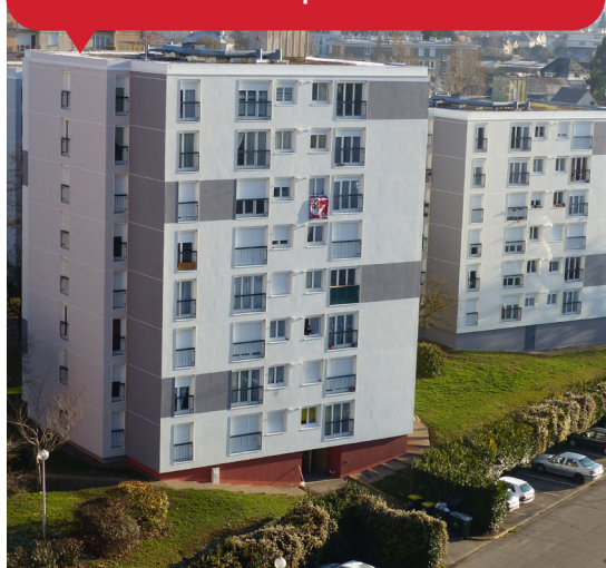
Immeuble après travaux
